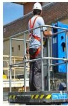
Figura 42. Operario con arnés y eslinga ajustable
