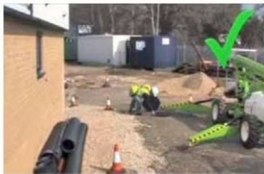
Figura 47. Evaluación previa de las condiciones de terreno.
