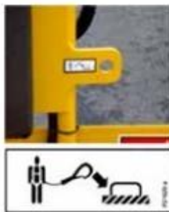
Figura 32. Señalización de punto de anclaje solo para retención
