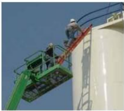
Figura 10. Acceso a una estructura utilizando medios auxiliares
